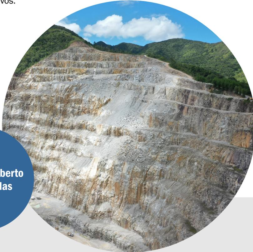
As etapas de mineração compreenderão basicamente as operações de decapeamento da jazida (remoção de estéril), perfuração da rocha, desmonte com uso de explosivo, carregamento e transporte do material de desmonte (minério) até a unidade de beneficiamento, onde ocorrerá o processamento, e expedição final.
